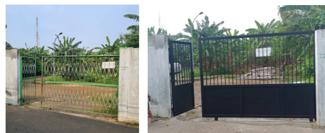
Gambar 49. Kondisi gerbang Gudang Arsip Ciganjur sebelum (kiri) dan setelah (kanan) direnovasi.
