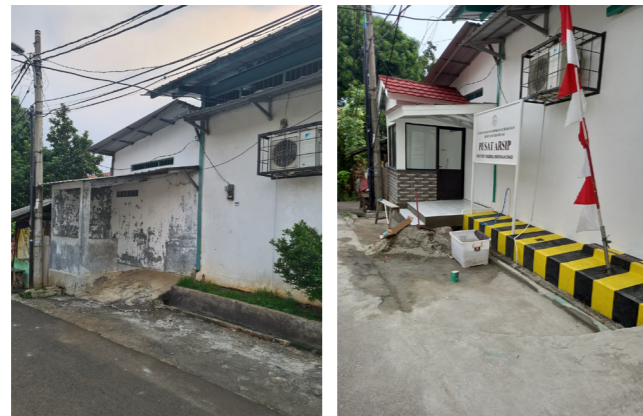
Gambar 47. Kondisi bagian depan Gudang Arsip Ciganjur sebelum (kiri) dan setelah (kanan) direnovasi.
