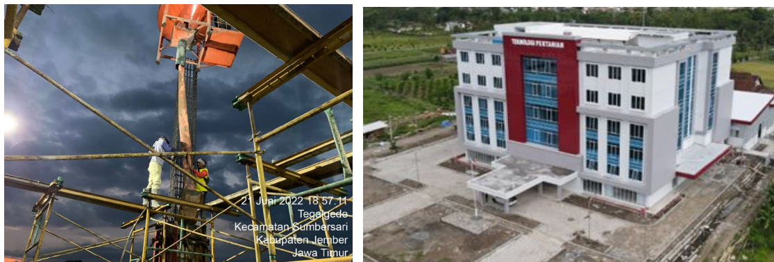
Gambar 3.4 Pembangunan Gedung Jurusan Teknologi Pertanian Politeknik Negeri Jember sumber dana SBSN
